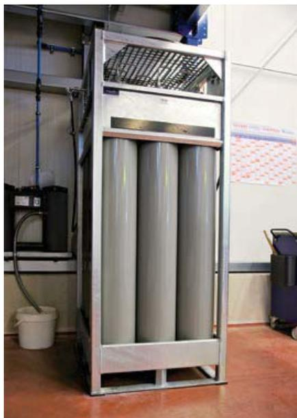
In dem Flaschenbündel kann der Stickstoff mit bis zu 300 bar zwischengespeichert werden. Bei Hohmann Gerätebau wird er über Nacht erzeugt und auf 200 bar verdichtet. Tagsüber, während der Produktion, wird der Stickstoff aus den Flaschen bis auf einen Restdruck zwischen 40 und 80 bar verbraucht.
