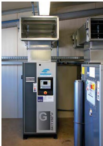
Zwei drehzahlgeregelte Kompressoren des Typs GA 11 VSD+ FF von Atlas Copco (einer rechts verdeckt) liefern die für die Stickstoffherzeugung und weitere Produktionsprozesse notwendige Druckluft. In der kalten Jahreszeit wird die aufgewärmte Kühlungsluft über eine Klappe oberhalb des Kompressors in die Halle geblasen. Im Sommer wird die Wärme nach draußen abgeleitet.
