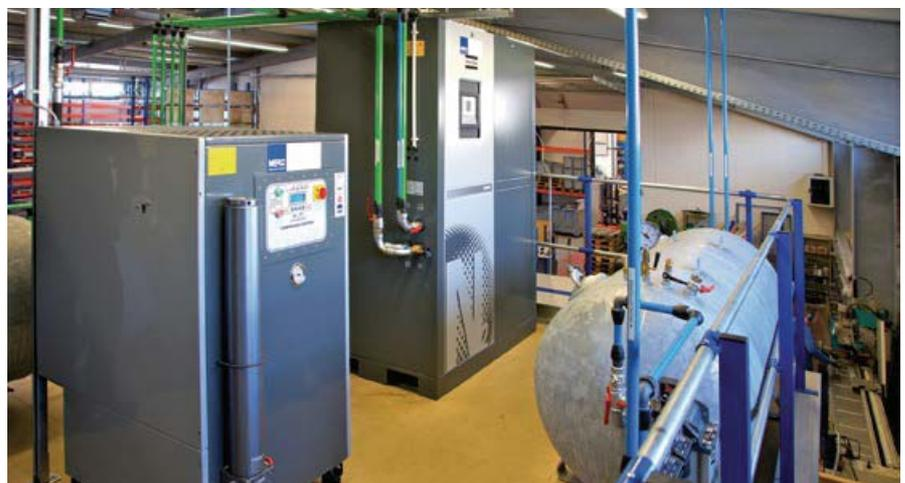
Stickstoffgenerator und Booster: Der im N<sub>2</sub>-Generator von Atlas Copco (hinten im Bild) erzeugte Stickstoff wird mit dem Booster auf bis zu 300 bar nachverdichtet und anschließend in einem Flaschenbündel zwischenspeichert. Die maximale Liefermenge der Anlage beträgt 12,6 m<sup>3</sup>/h bei Qualität 5.0 bezogen auf einen Eingangsdruck von 7,5 bar.
